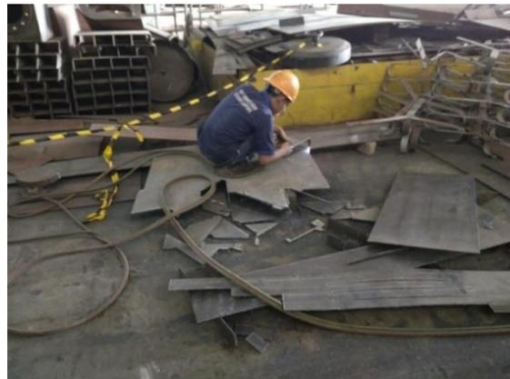
**Gambar 8.** Pemotongan Plat Baja Secara Manual
