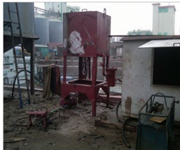
Gambar 5. Bak Pasir Untuk Sand Blasting PT. JMI
