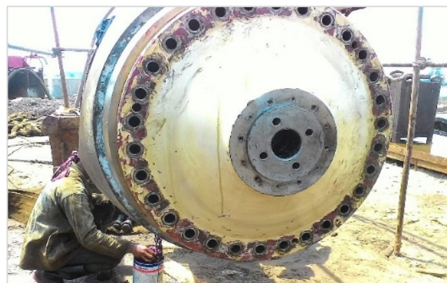
Gambar 7. Proses Perbaikan CPP Sumber: Dokumen Penelitian, 2019
