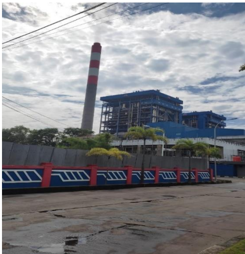
Gambar 2 PLTU Cilacap PT S2P Sumber: Dokumentasi peneliti, 2022
