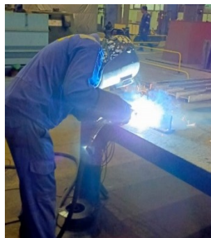
Gambar 1. Proses Pengelasan FCAW Sumber: Dokumen Pribadi (2024)
